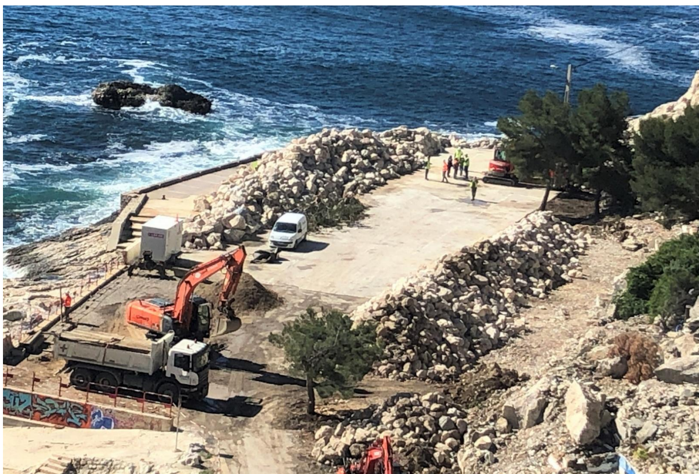
La Vesse durant les travaux, le 12/05/2020
