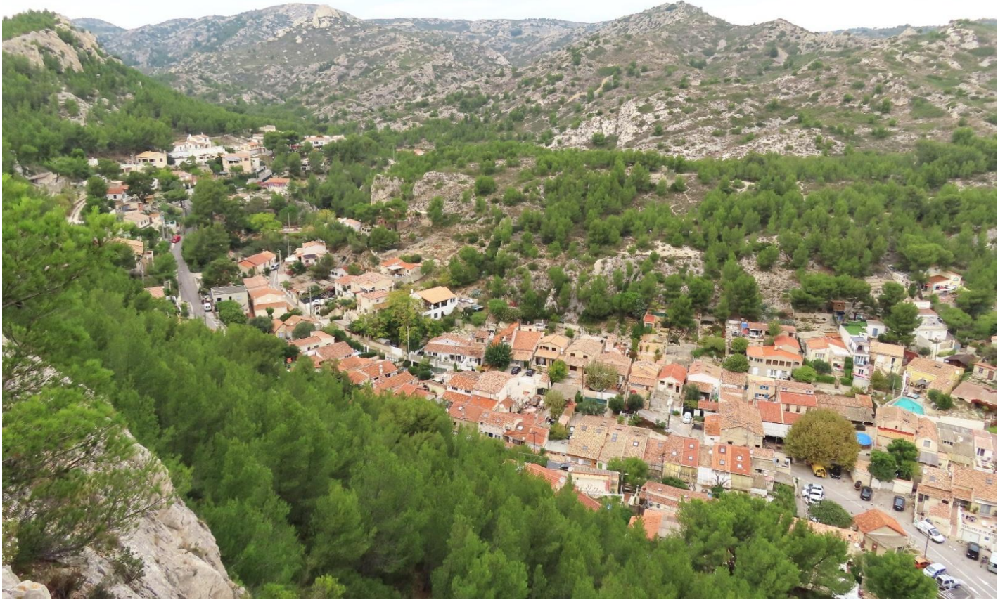
Une partie du village (photo DF)
