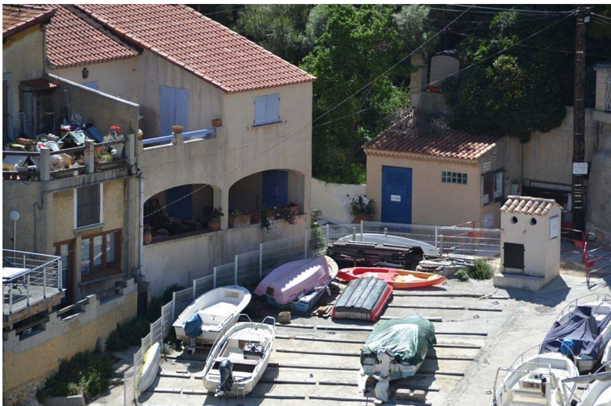
2020, le glais avant réfection
