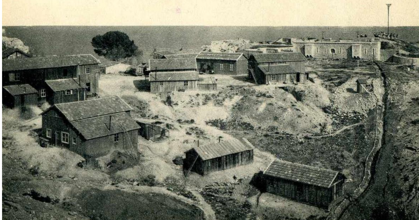
Habitations pour la construction du chantier, vers 1911
