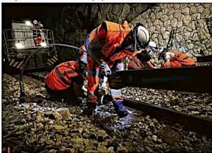
Mise en place du rail neuf, à droite, va être mise en place à l'aide d'une étréole. (PHOTOS: L. L.)
