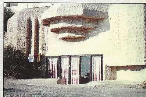
Batterie de Niolon bas : casemate M272 de marine armée d'un 90 mm M 39 (f) sous masque de blindage. (SHM 1947) Vue actuelle de cette même casemate transformée en habitation (Photo M. Begues.)
