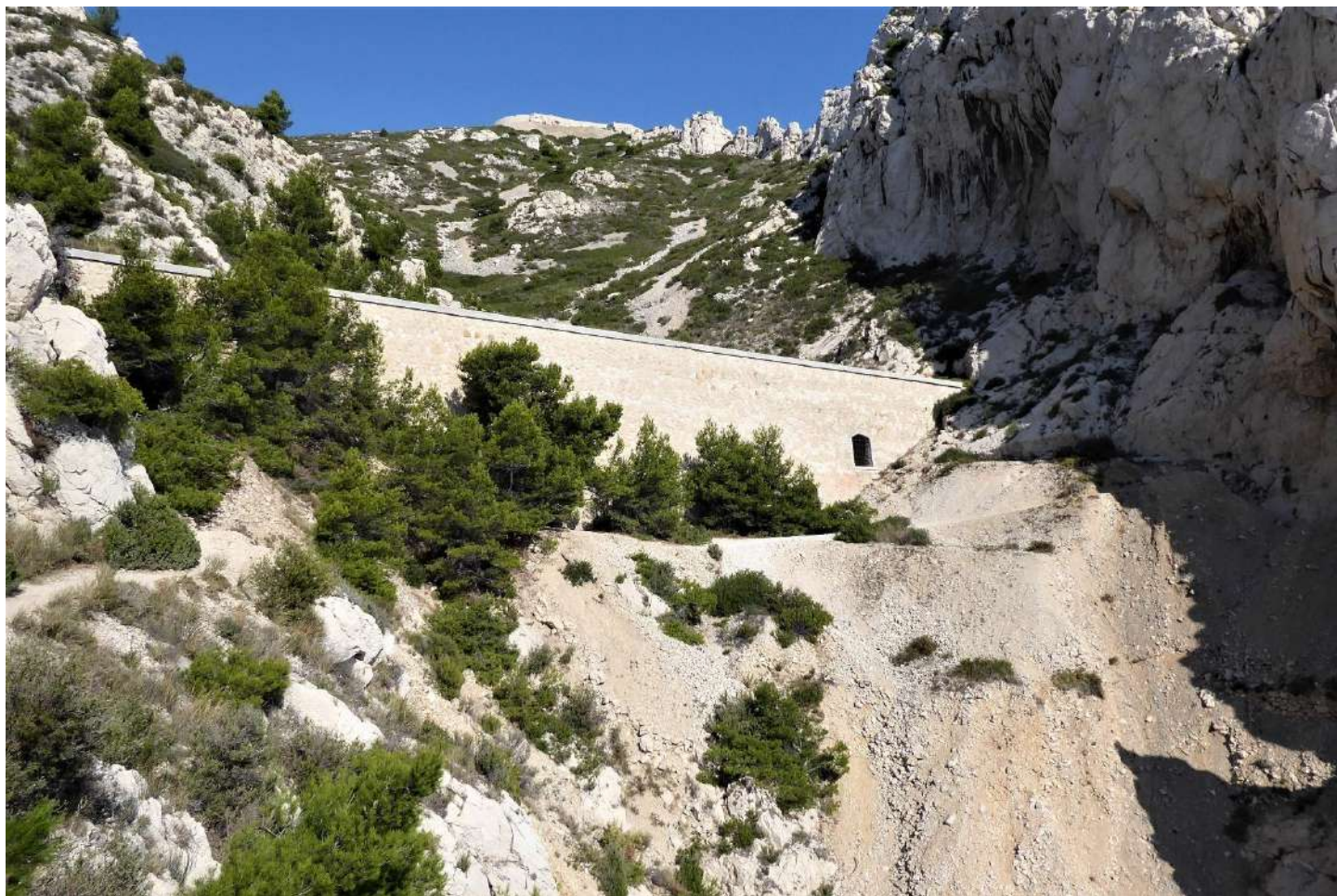
Tunnel ferroviaire du Riflard (photo DF)
