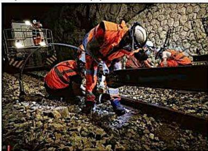
Mise en place des rails de la ligne de la Côte bleue. Le rail neuf, à droite, va être mis en place à l'aide d'une étréole. (photos : S. G.)
