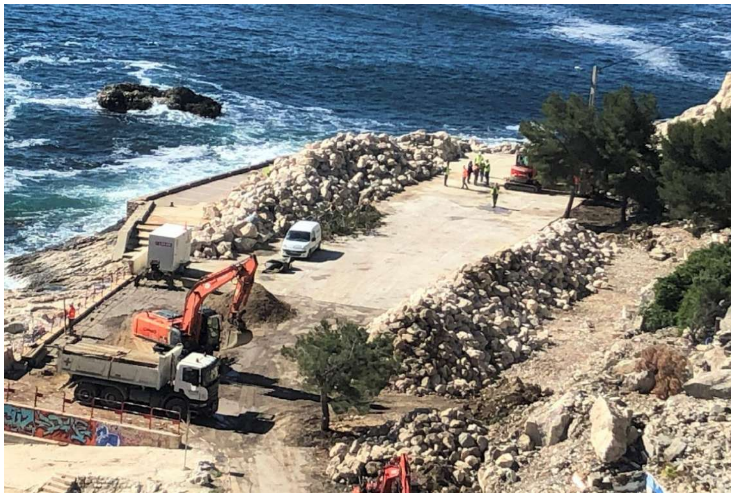
La Vesse durant les travaux, le 12/05/2020
