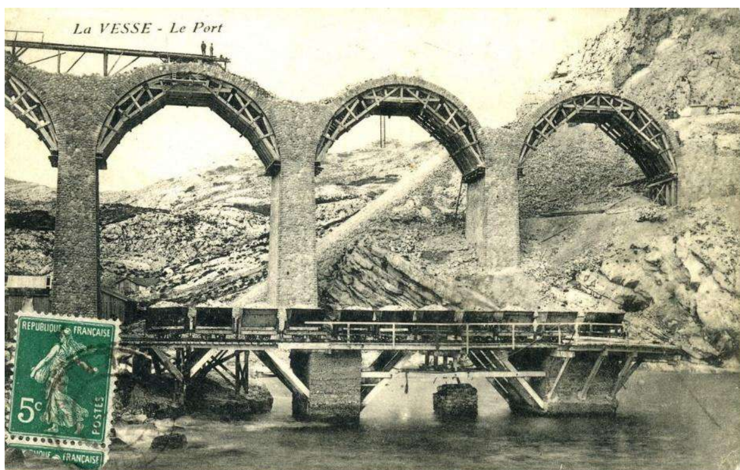
La Vesse, quai accueillant des wagonnets sur rail afin de recevoir les matériaux venus par mer, vers 1912
