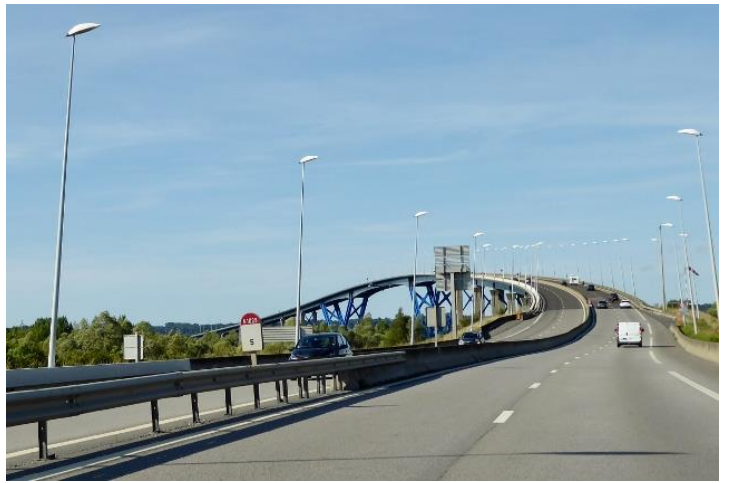
Pont de Normandie
