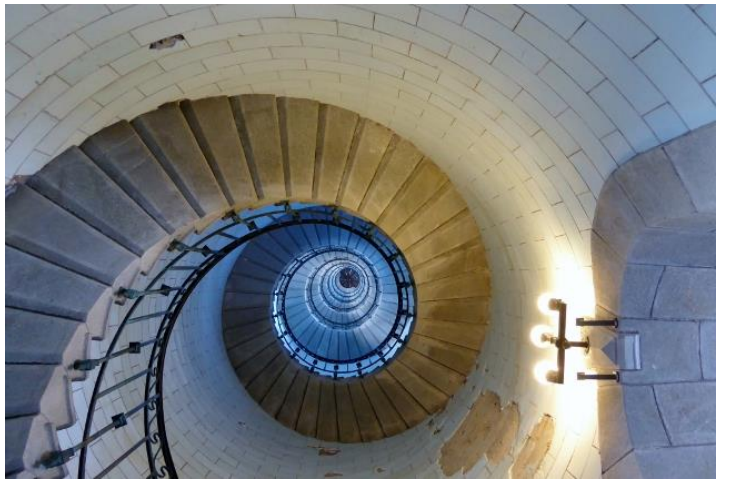
Escaliers du phare d'Eckmühl (1897, 65 m), Penmarc'h
